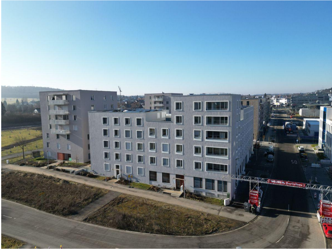
Ansicht von außen
